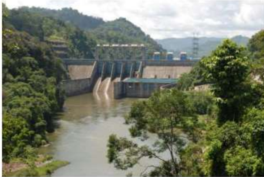
Bendungan Waduk PLTA Koto Panjang memblokir ruaya ikan (dokumen Aryani, 2014)
