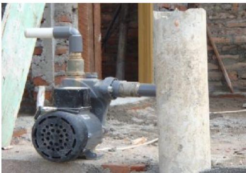
Gambar 5. Sumur bor dan pompa telah terpasang dengan kedalaman 40 m
