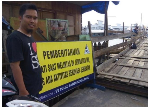
Gambar 1. Rehab Jembatan Sungai Perigi I CSR PT. PSK
