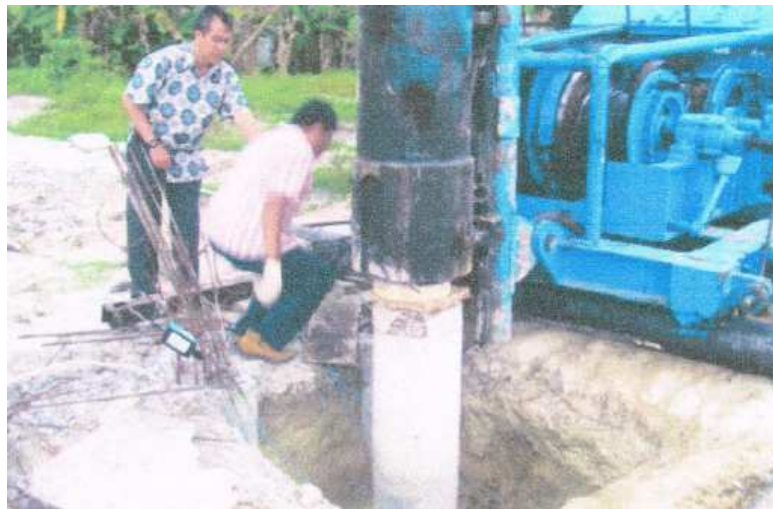
Gambar 1. Pengujian Tiang Pancang P08/147.1
