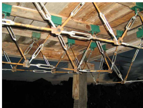
Gambar 4. Uji Eksperimen Aplikasi Pengecoran Lantai Rumah Tinggal
