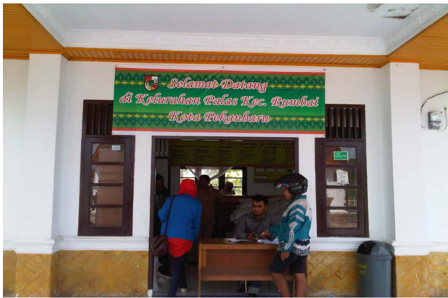
Kantor Kelurahan Palas Kecamatan Rumbai-Riau
