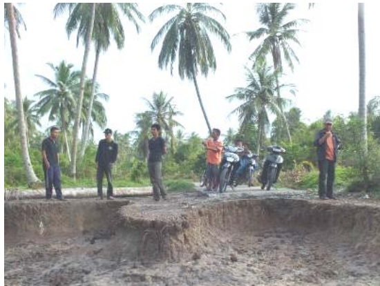
Gambar 5.6. Kondisi Pantai Pulau Rangsang
