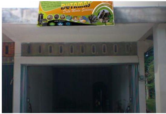
Gambar 4. Perbaikan Ruang Pengolahan Madu UKM Dutamas (Kondisi 100%)
