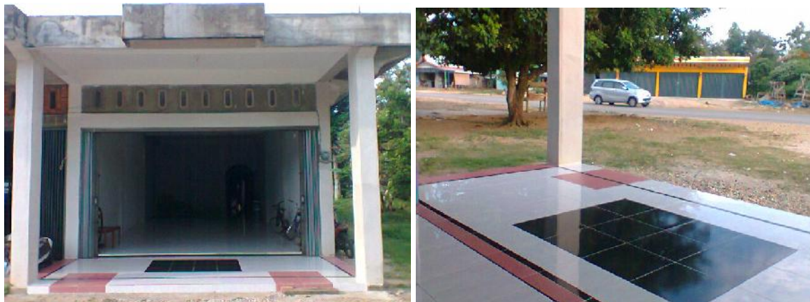
Gambar 3. Perbaikan Ruang Pengolahan Madu UKM Dutamas (Kondisi 70%)
