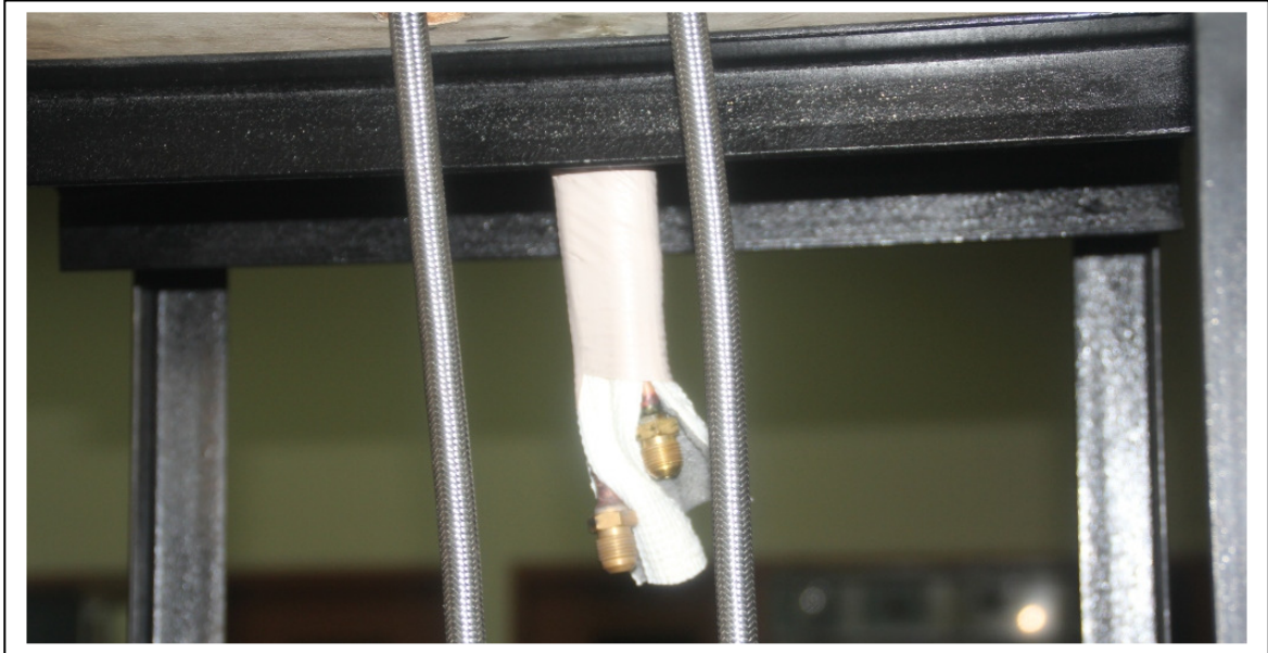
Gambar L2.11. Inlet dan outlet Kondensor dummy setelah dipasang pada instalasi sistem
