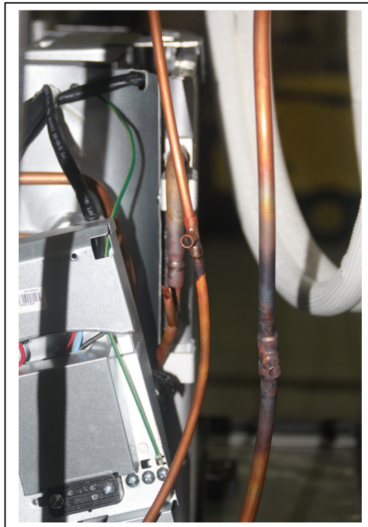
Gambar L2.12. Proses instalasi pengukur tekanan sistem
