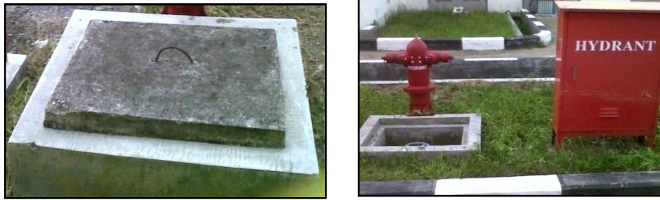
Gambar 1. Sumber air dan hidran halaman
