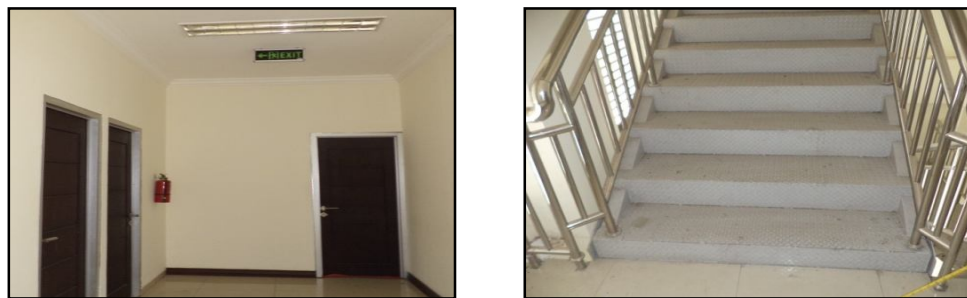
Gambar 2. Sarana jalan keluar dan tangga darurat
