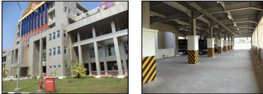
Gambar 4. Konstruksi bangunan gedung
