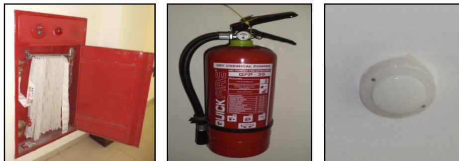
Gambar 3. Kelengkapan proteksi aktif
