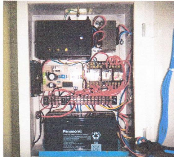
Gambar 12. Unit aktuator yang terakit dalam panel
