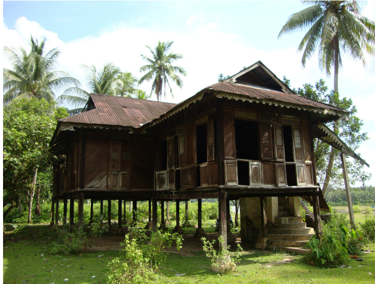
Gambar 1. Arsitektur Melayu dengan bentuk Atap lipat Kajang memiliki tiang panggung yang tinggi dan ventilasi yang cukup dalam bangunan. Lokasi Kuok, Kampar. (Sumber: dokumen pribadi)
