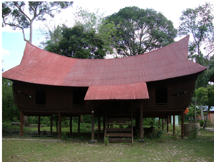
Gambar 2. Atap lebar pada arsitektur Melayu bentuk Atap Lontek memungkinkan penghiadaran masuknya sinar matahari secara langsung ke dalam bangunan dan menghindari efek silau. Lokasi Kuok, Kampar. (Sumber: dokumen pribadi)
