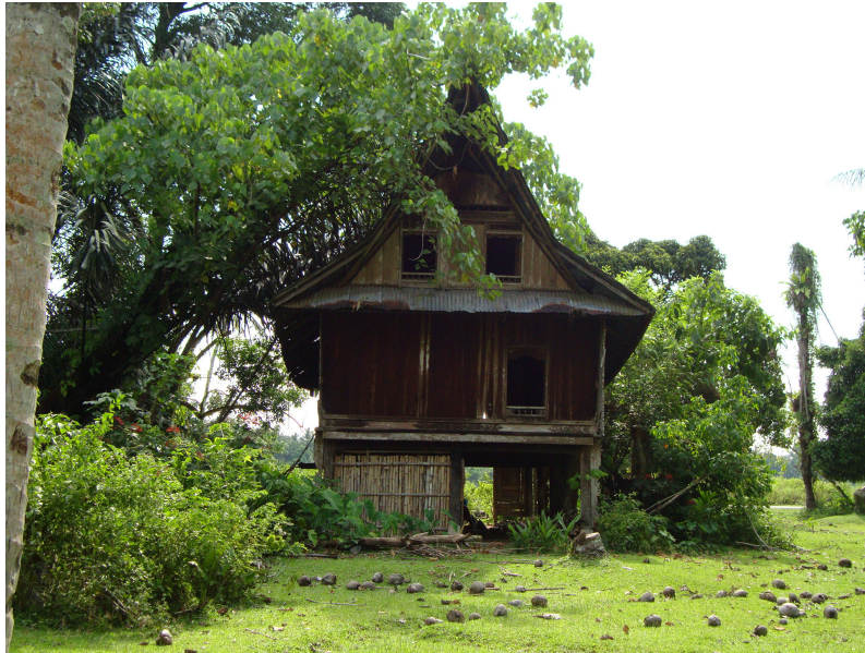
Gambar 3. Perancangan bukaan pada bagian atap memungkinkan penghawaan mengalir lancar di bagian atas bangunan. Lokasi Kuok, Kampar. (Sumber: dokumen pribadi)
