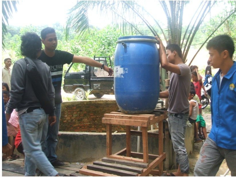
Gambar 2. Perakitan alat penyaringan pasir lambat UP FLOW
