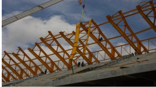
Gambar 3. Bengkoknya struktur baja karena tiupan angin kencang
