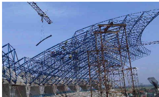
Gambar 2. Struktur space truss
