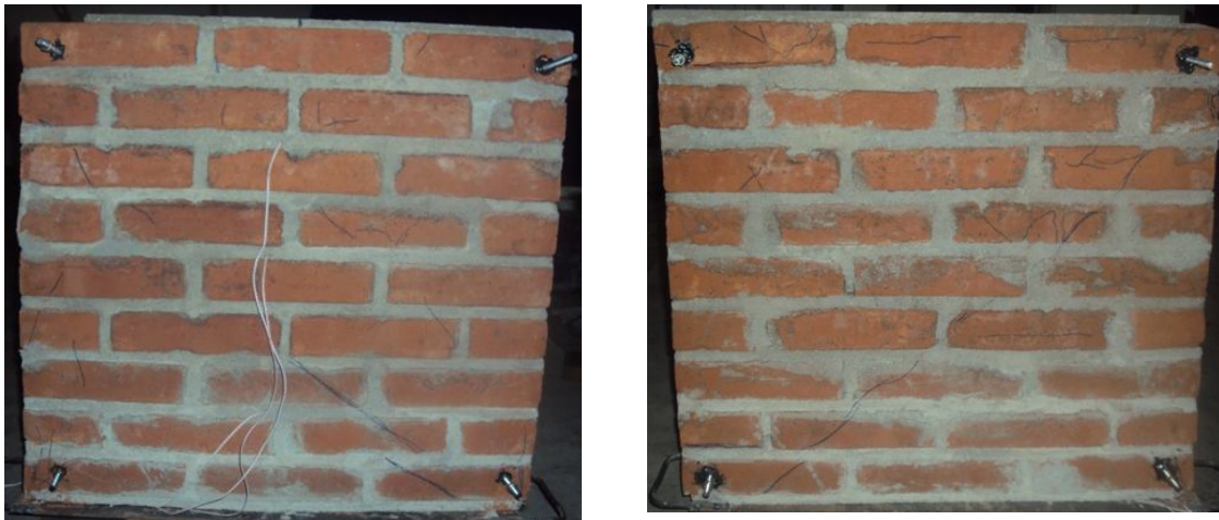
Gambar 5.26. Pola retak dan keruntuhan benda uji RM-C
