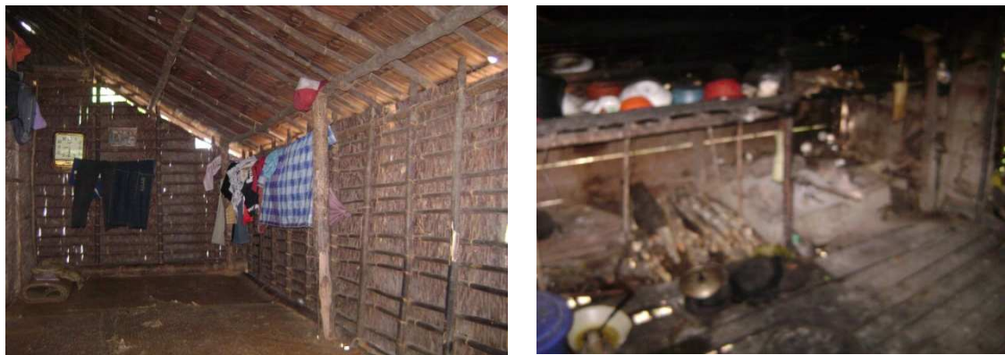
Gambar 4.12. Situasi di dalam rumah orang Talang Mamak (kiri); Situasi dapur dengan penggunaan tungku dalam rumah orang Talang Mamak (kanan). (Dokumentasi Penelitian, 2012)
