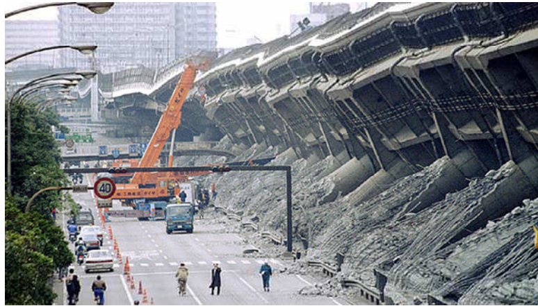
Gambar.1 Keruntuhan Higashi-Nada Viaduct pada tahun 1995 akibat gempa Kobe (Chen & Duan, 2003)
