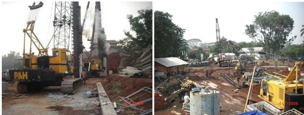
Gambar 1. Pemancangan Tiang Pancang
